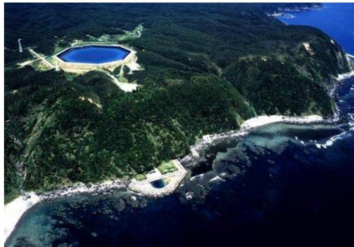
2.30. ábra: Szivattyús tározós vízerőmű madártávlatból
