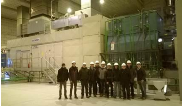
2.11. ábra: Kombinált ciklusú erőmű gázturbinájának a háza és a villamos generátor
