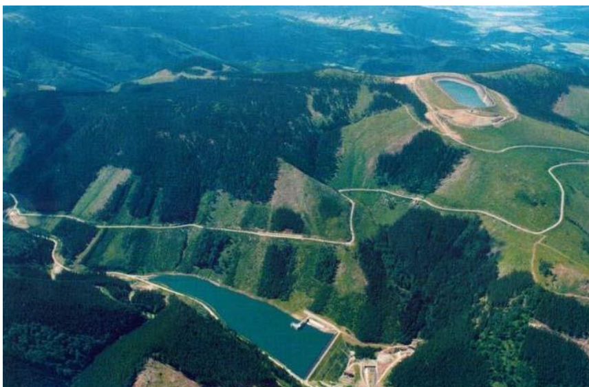
2.31. ábra: Szivattyús tározós vízerőmű madártávlatból
