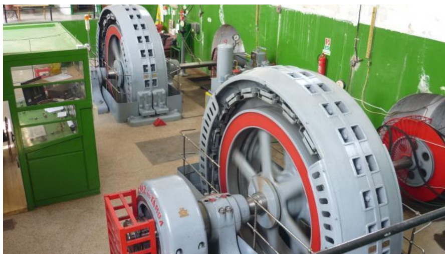
6.4. ábra: Szinkron generátor a gibárti vízerőműben a Hernád folyón
