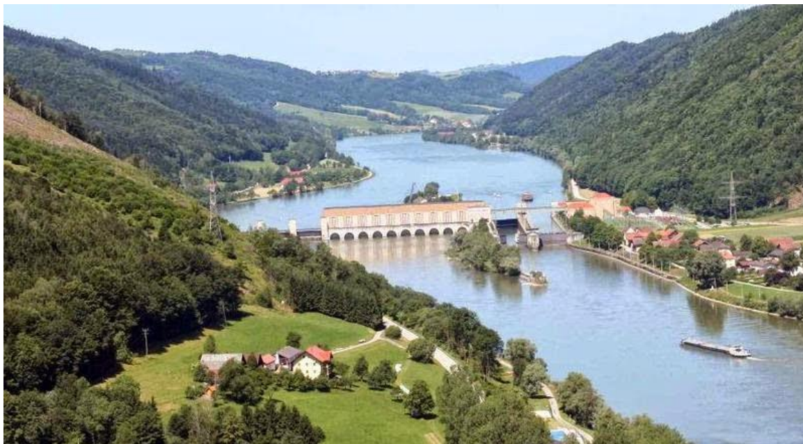
2.23. ábra: Folyóvízi, völgyzárógátas erőmű
