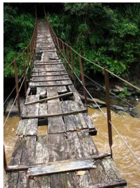
2.6. ábra. A függőhíd üzenete: megbízhatatlan, életveszélyes szerkezet
