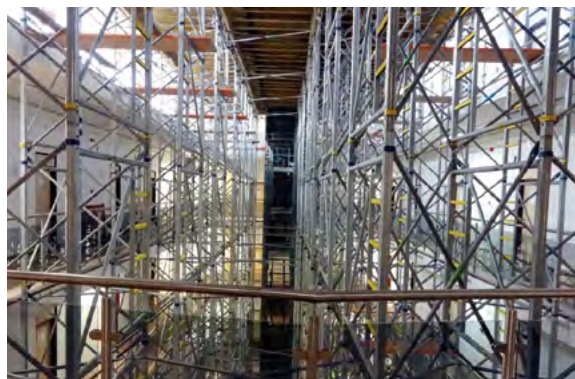
Az A/4. épület felülvilágítójának cseréje: állványzat
