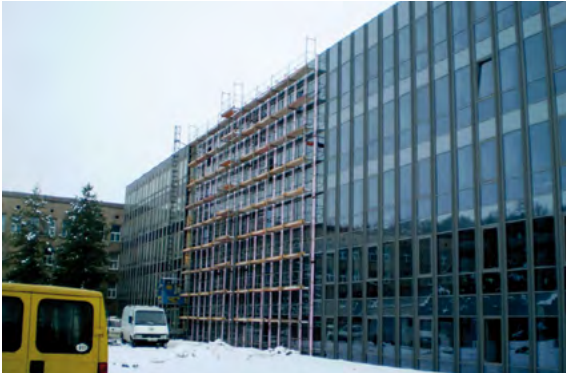
Az A/4. épület felújítása: új rész, munkaterület, régi rész
