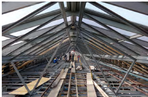
Az A/4. épület felülvilágítójának cseréje: munkák a tetőtérben
