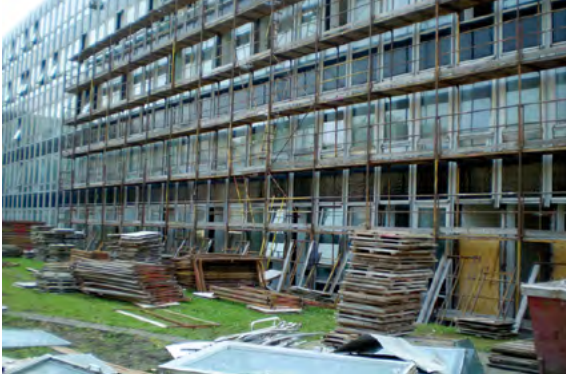
Az A/4. épület homlokzatának cseréje az első ütemben
