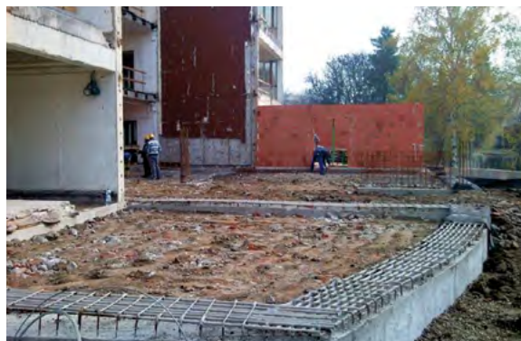
Az Informatika épület bővítvényének alapozása
