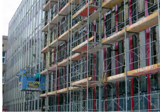
Az ütemek határa az A/4. épület felújítása során
